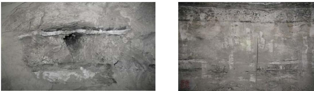
Рис.1. – Визуальный способ определения зон разрушения, измерения размеров зоны дробления, зоны кольцевых трещин и зоны радиальных трещин вокруг «стаканов» в забое камеры
